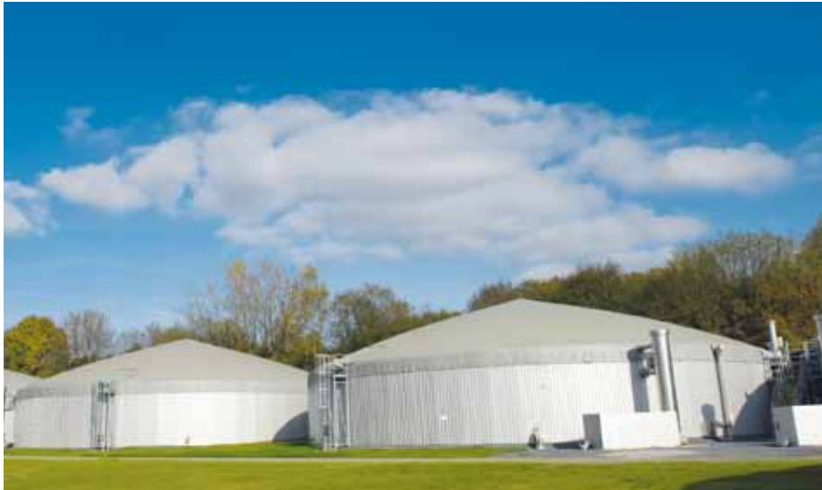
Installation de biométhanisation à l'usine de Libramont, première usine du groupe 100% énergie verte.
